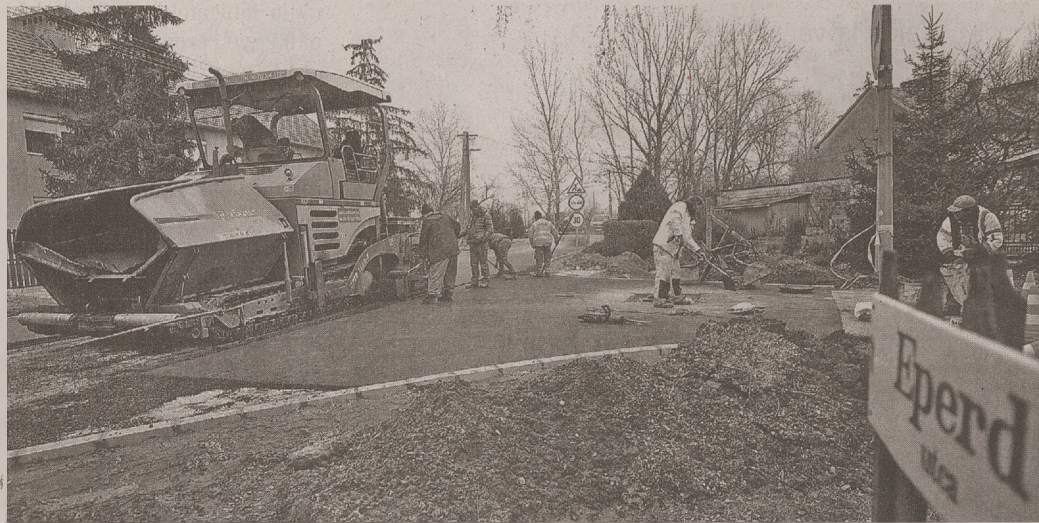
Új aszfaltréteg került burkolatként az utcákba
